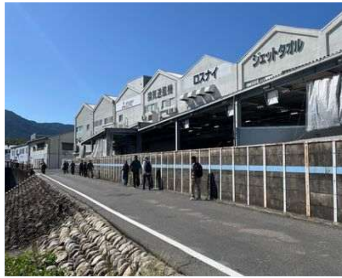
01 三菱電機 中津川製作所のフェンスを進む
