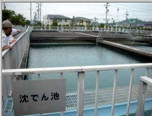
沈殿池 フロックを沈殿させる池
