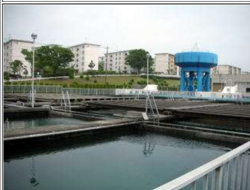
フロック形成池 薬品を入れて濁質を結合させる
