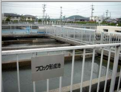
フロック形成池 薬品を入れて濁質を結合させる
