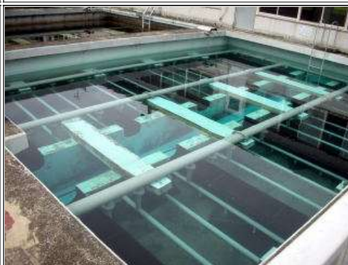
沈殿池 フロックを沈殿させる池
